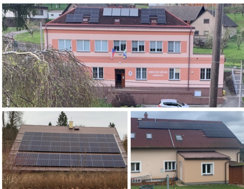
Obrázek 13 Instalace solárních panelů na střechách obecních budov
