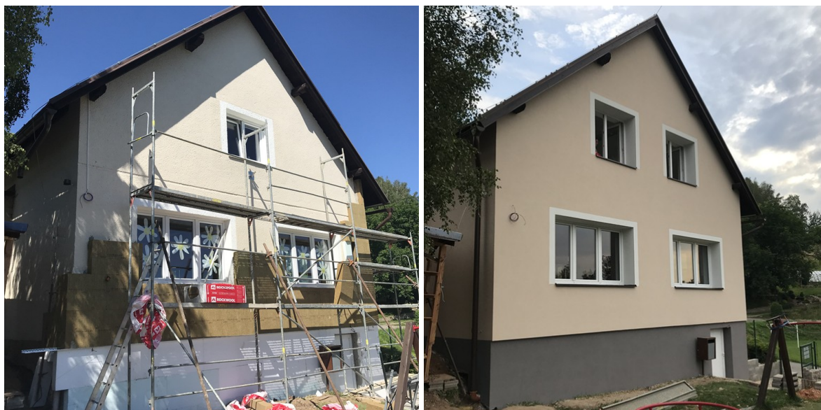
Obrázek 10 Ukázka zateplení fasády MŠ kamennou vlnou ROCKWOOL a polystyrenem
